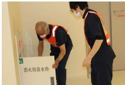
↑消火ホースを準備しています
